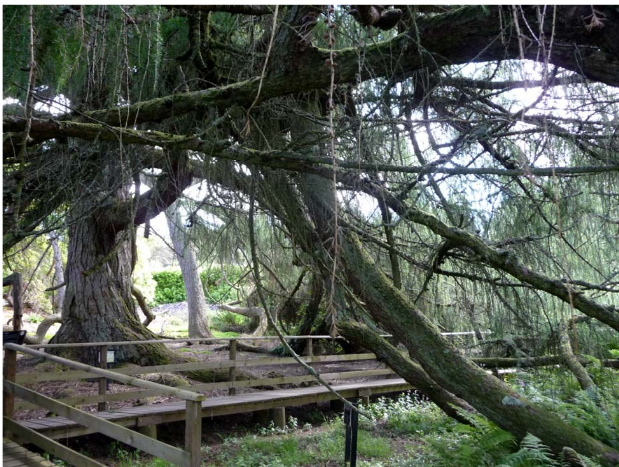
Fig. 3.6: skydd av rötter genom anläggande av en upphöjd spång vid träd med mycket höga värden i ett välbesökt område.
